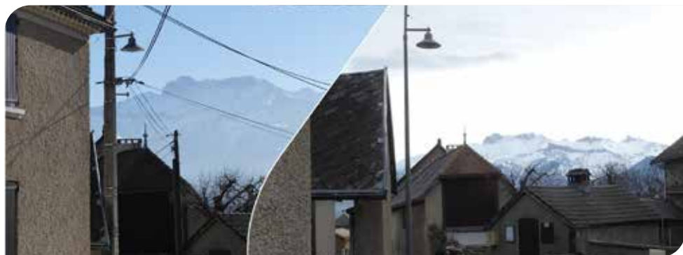
Avant - Après : enfouissement des réseaux
